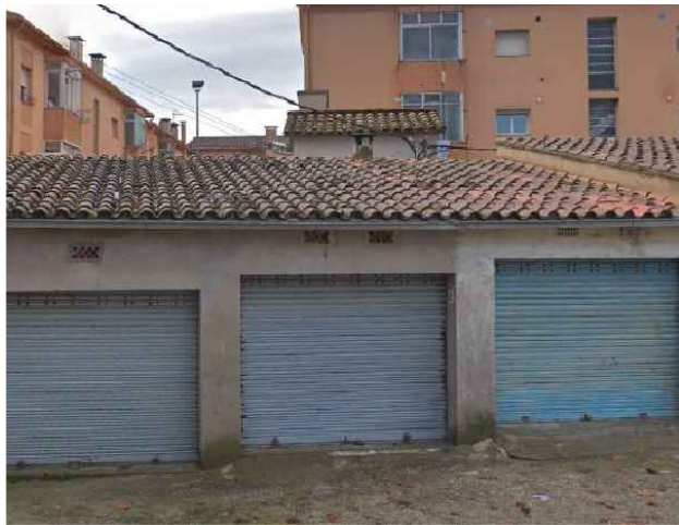
Imatge 3. Vista frontal construccions en filera.
